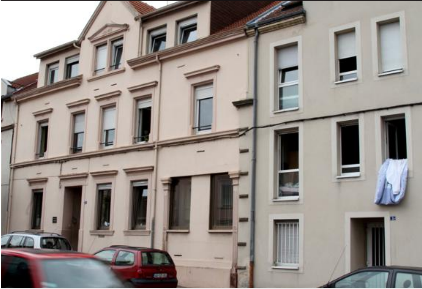
Les trois maisons situées au 2E, 2D et 2F vont être totalement modernisées. Les travaux de réhabilitation sont financés, mais l'association a maintenant besoin d'argent pour acheter du mobilier pour équiper les logements.
